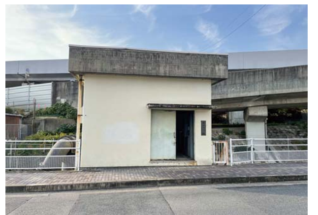
横浜ポンプ場
