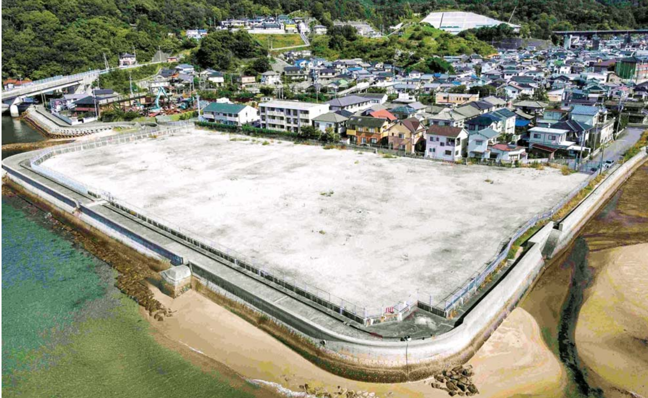
（仮称）小屋浦住宅用地敷地整備工事 着手前の状況
