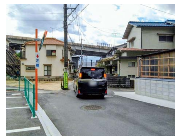
町道浜田中洲線の拡幅
