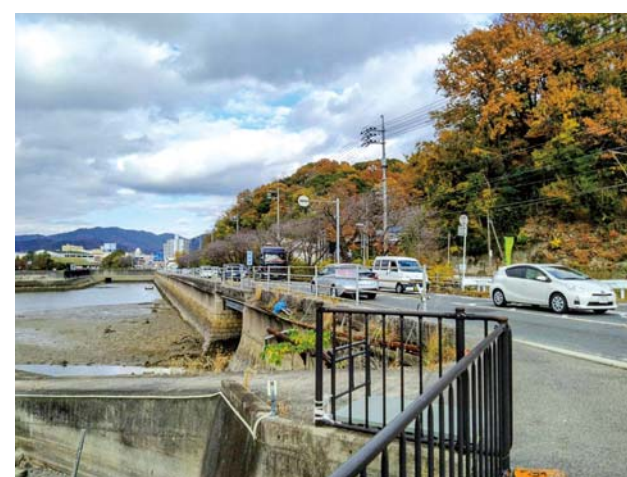
国道31号歩道拡幅整備
