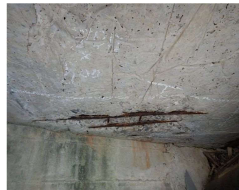
コンクリート床版の鉄筋露出
