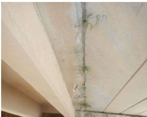
コンクリート床版の漏水・遊離石灰
