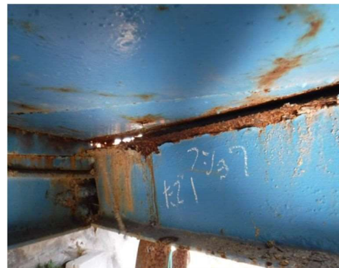
横桁・縦桁等の腐食
