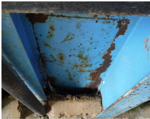
鋼床版の腐食・防食機能の劣化
