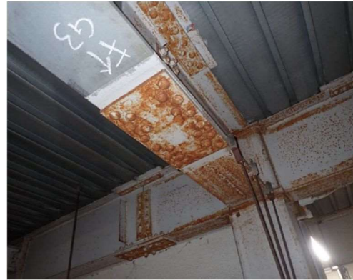
主桁の防食機能の劣化
