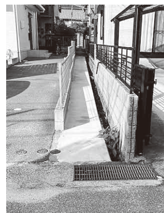
横浜西一丁目 里道部の舗装
