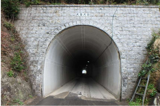
【上条トンネル 起点側（植田側）】
