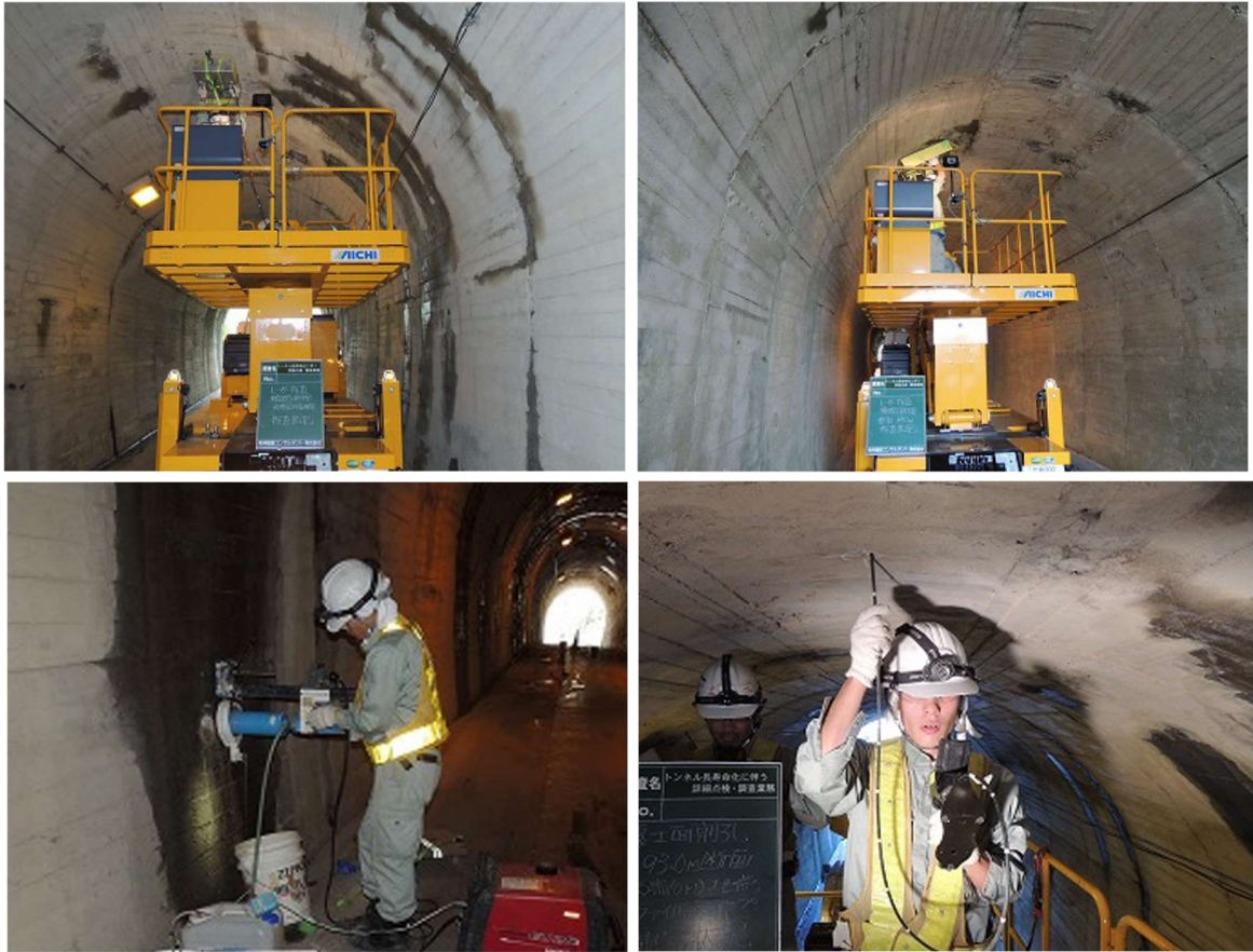
トンネル点検状況
