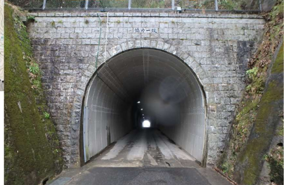
【上条トンネル 終点側（坂西側）】
