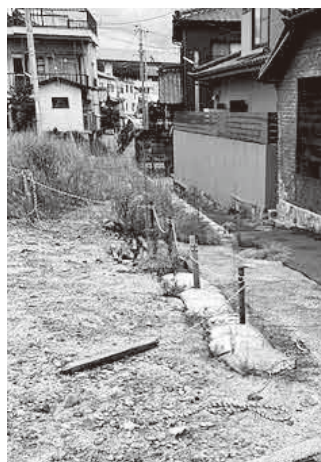
横浜中央三丁目7番街区土のう設置
