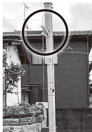
横浜中央三丁目9番街区外灯設置
