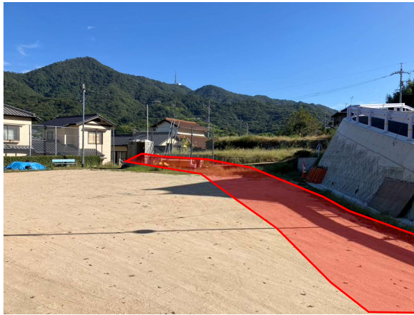
◀西側9号線道路改良工事
