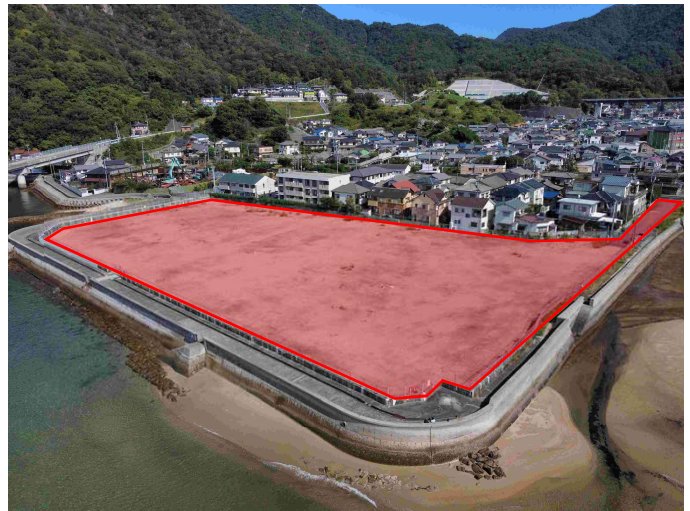
▲(仮称)小屋浦住宅用地敷地整備工事
