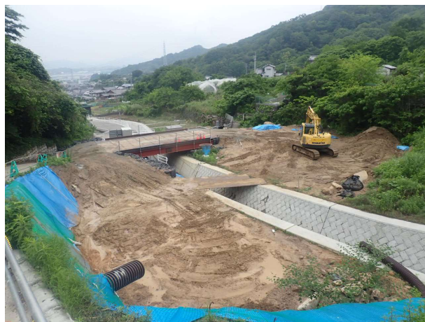
▲坂東環状線（仮称）明神橋橋梁下部工事 基礎工（場所打杭工）の打設が終わり、橋台の床掘りを施工しています。
