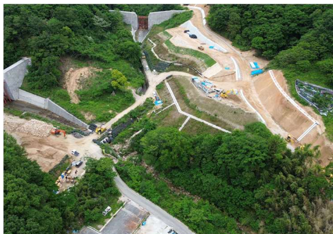
▲安芸南部山系付替町道坂・小屋浦線道路改良工事
