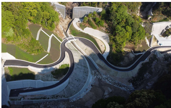
▲その他河川天地川砂防激甚災害対策特別緊急工事（管理用道路）
