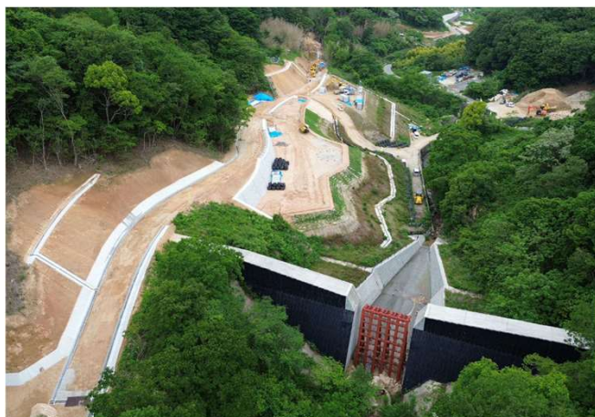
▲安芸南部山系総頭川遊砂地第2工事
