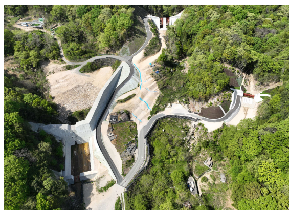
▲（仮称）天地川支川1通常砂防工事（管理用道路・溪流保全工）
