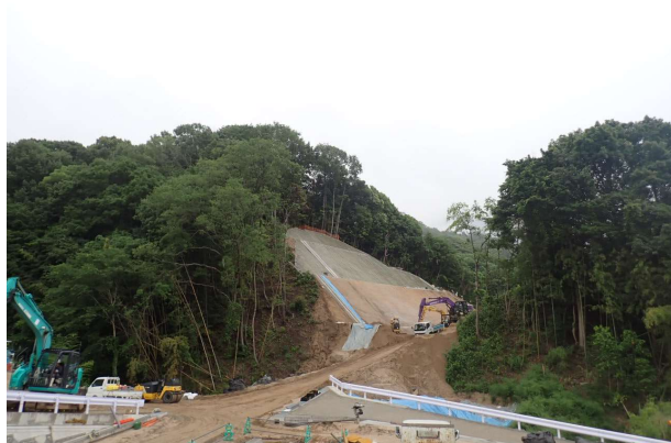
▲坂東環状線道路改良（その3）工事 道路土工（掘削）等の施工を進めながら、法面工に着手しています。
