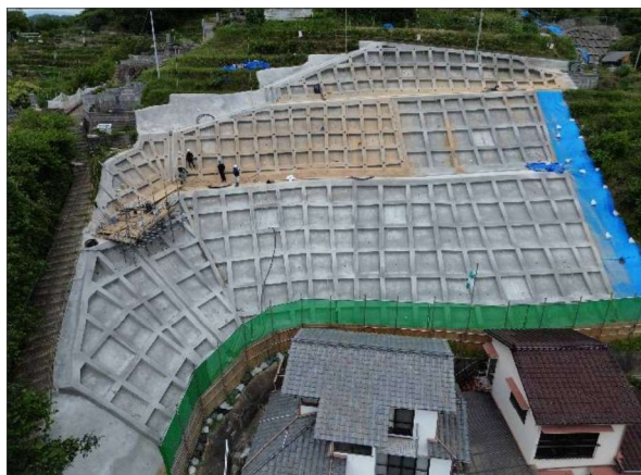
▲坂東環状線道路改良（その3）工事 道路土工（掘削）等の施工を進めながら、法面工に着手しています。
