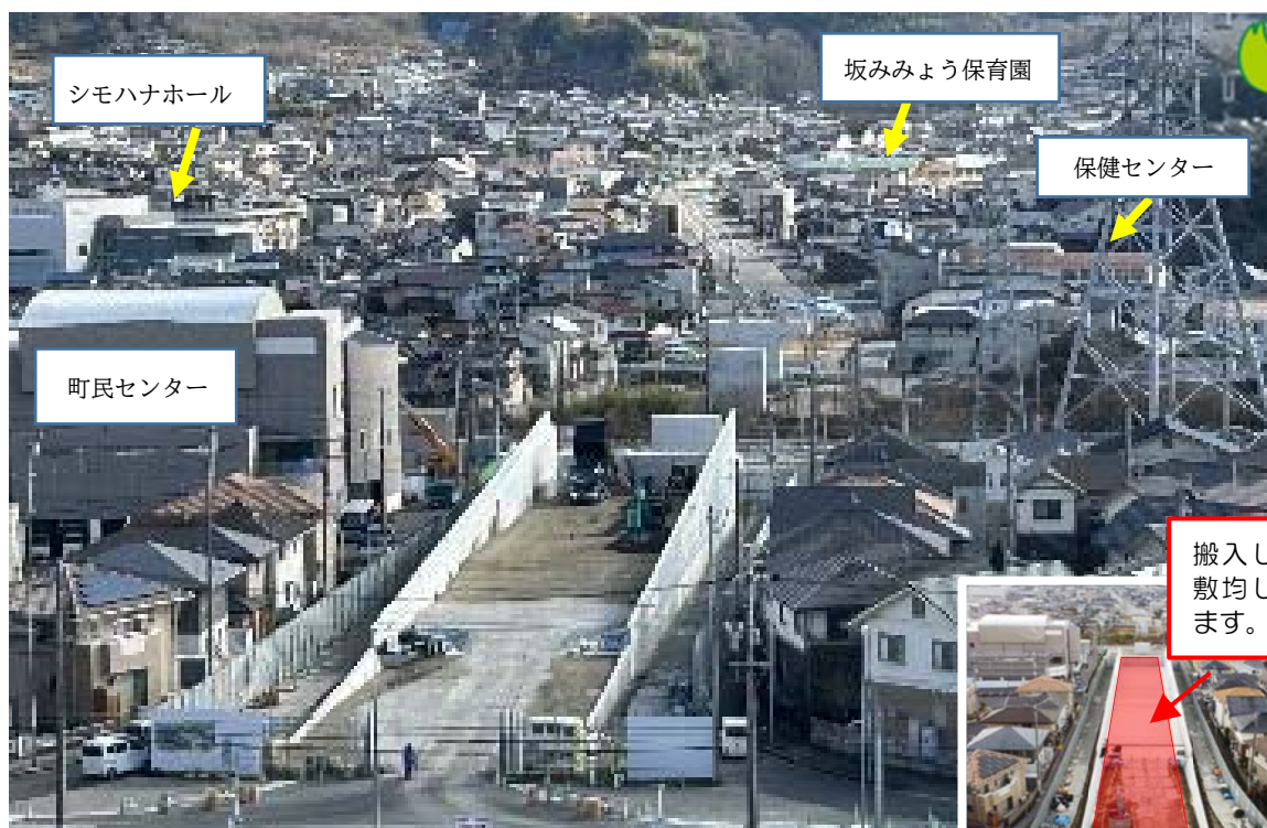
U型擁壁工事 施工状況
