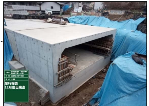
ボックスカルバート③施工状況
