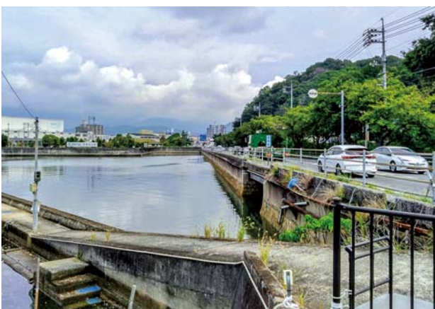
海を埋め立てて車道・歩道を整備
