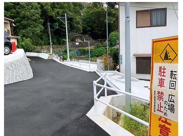
完成した横浜一部15号線
