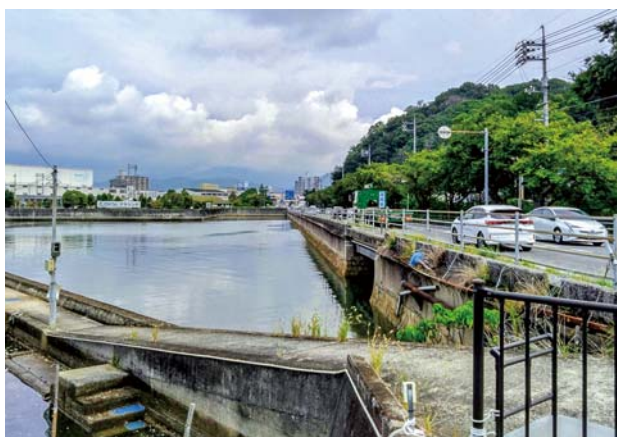
海を埋め立てて車道・歩道を整備
