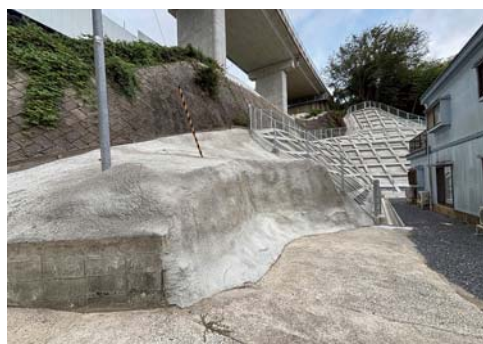
水尻9063地区急傾斜地崩壊対策事業
