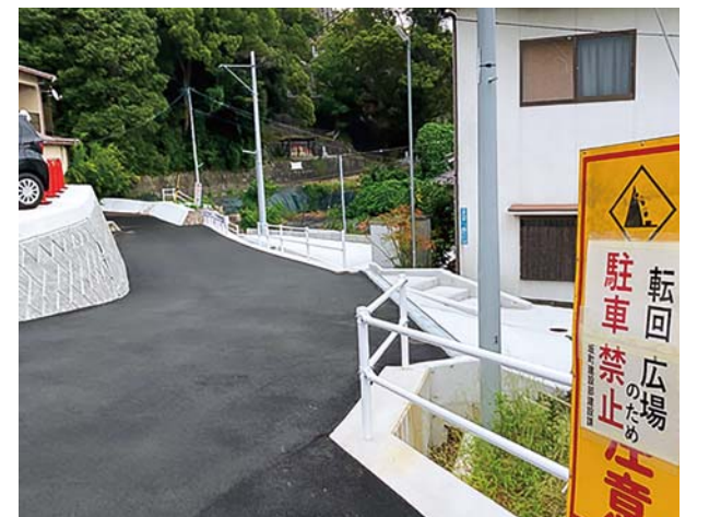
完成した横浜一部15号線
