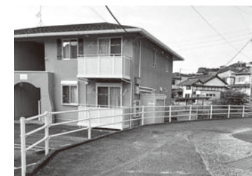
坂東二丁目23番街区 防護柵設置
