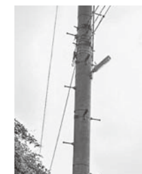
坂東四丁目16番街区 外灯設置
