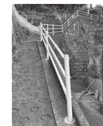
坂東四丁目26番街区 手すりの設置
