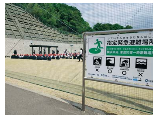
横浜中央の津波災害一時避難場所
