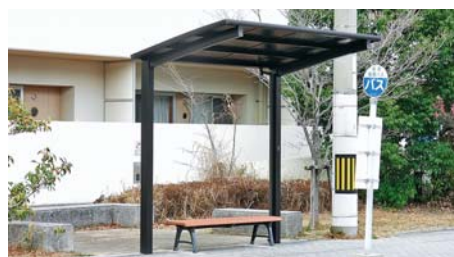
県営住宅前のバス停留所
