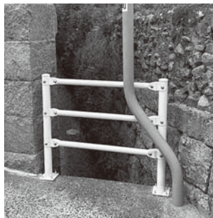
8番街区 防護柵の設置
