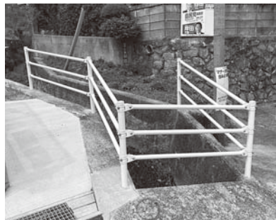
22番街区 防護柵の設置
