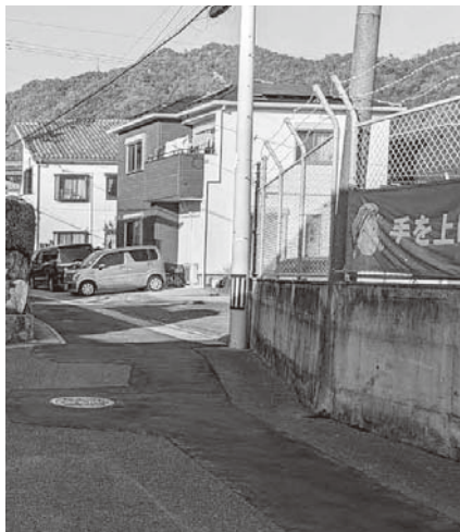
マンホール周辺の整備
