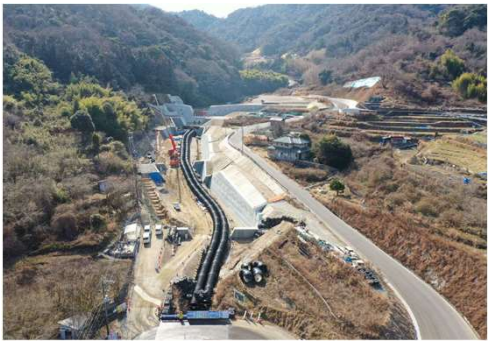
総頭川（総頭山：国土交通省施工）
