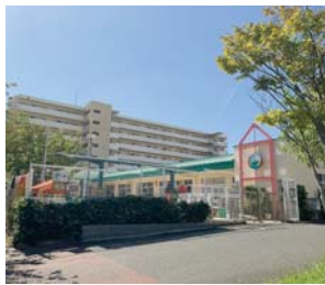
平成ヶ浜住宅1号館
