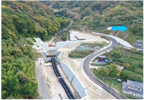
総頭川（総頭山：国土交通省施工）
