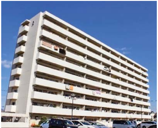
平成ヶ浜住宅3号館
