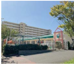
平成ヶ浜住宅1号館
