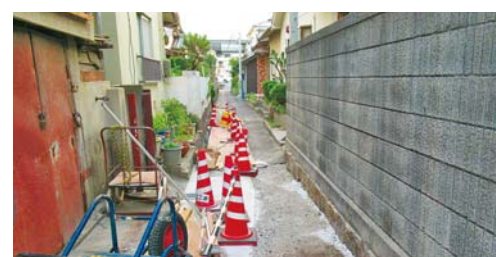
雨水排水路の改良工事を早く
