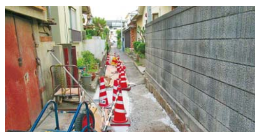
雨水排水路の改良工事を早く
