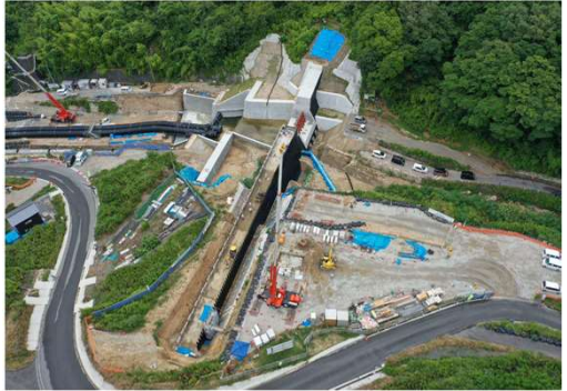
総頭川（総頭山：国土交通省施工）
