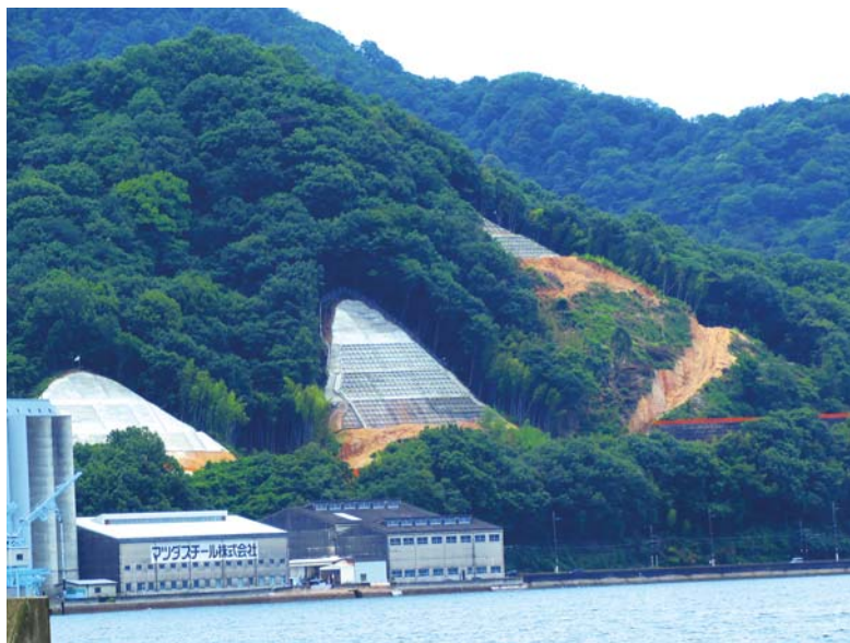
町道植田水尻側道線
