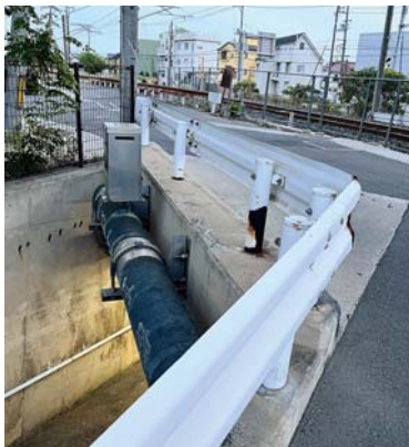
坂西一丁目地下道付近
