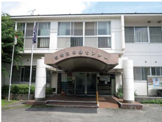
経年劣化の進む保健センター
