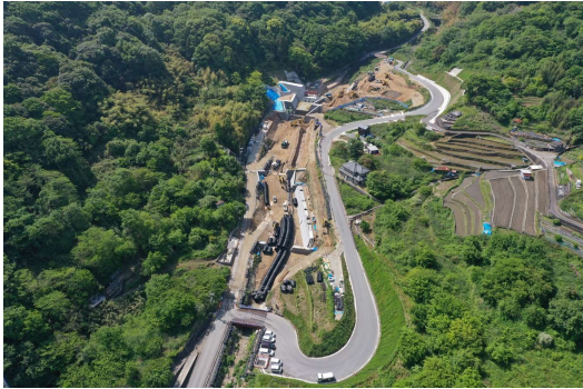
総頭川（総頭山：国土交通省施工）
