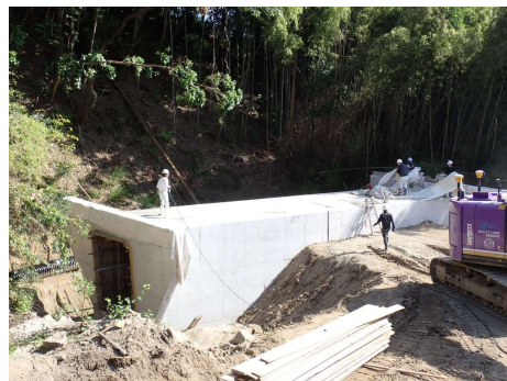
▲ボックスカルバート完成後
