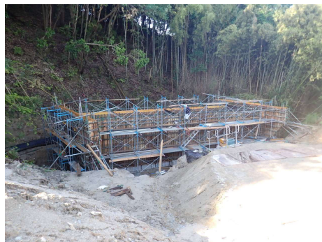
▲ボックスカルバート完成前
