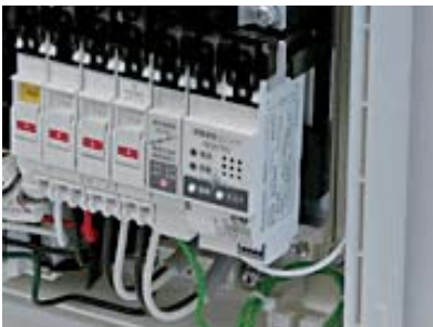
震度5で遮断する感震ブレーカー
