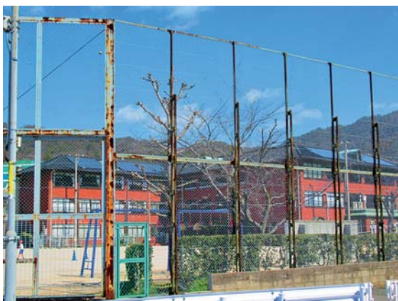
古くなった小学校グラウンドフェンス改修
