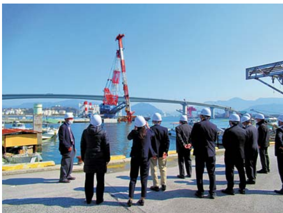
森山北防波堤工事
