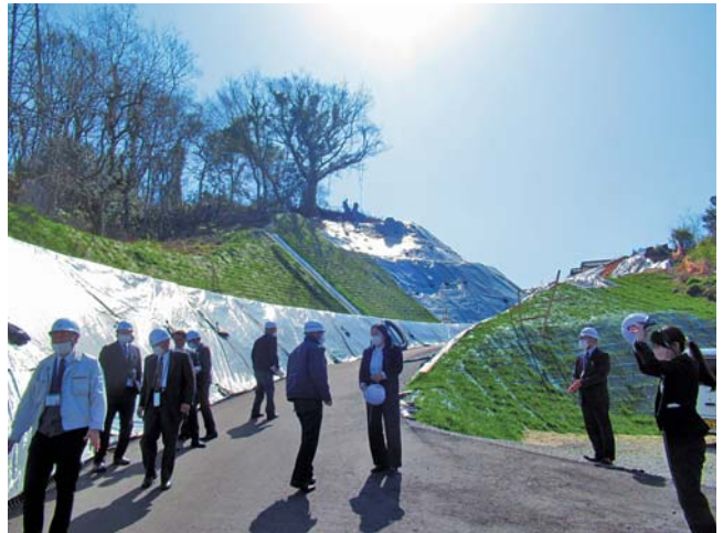
整備中の坂東環状線
