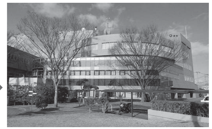
写真③令和6年1月の坂町役場
