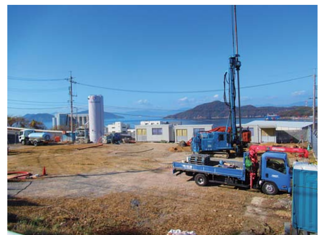
工事が始まった植田四丁目の整備箇所
