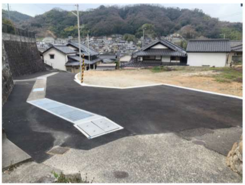
▲勿4号線道路改良工事 道路拡幅の工事が完了しました。
