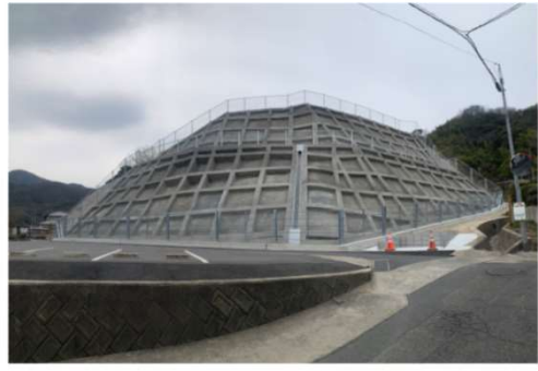
▲坂西二丁目地区急傾斜地崩壊対策工事 急傾斜地崩壊対策の工事が完了しました。
