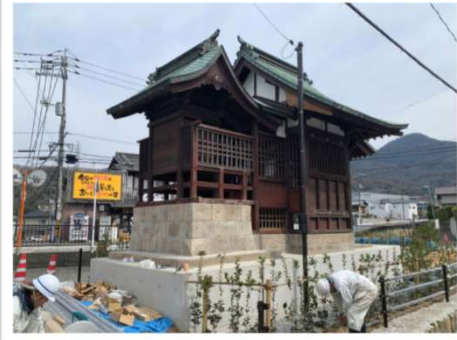
▲姫宮神社移設工事 姫宮神社の移設工事が完了しました。
