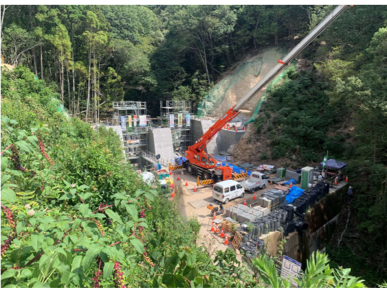
天地川支川1-2(小屋浦地区：広島県施工)
