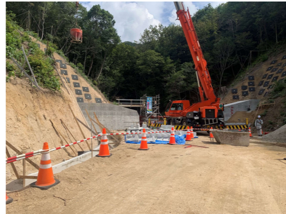
天地川支川1-5 (小屋浦地区：広島県施工)
