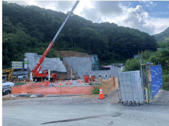
総頭川 (総頭山：国土交通省施工)
