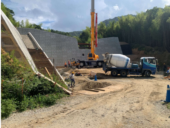
水尻支川4 (水尻地区：広島県施工)
