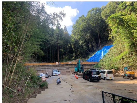
手切川 (植田地区：広島県施工)
