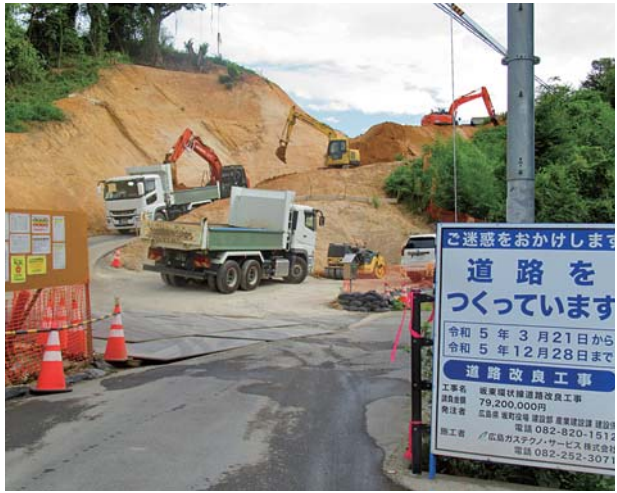
坂東環状線の八幡神社裏の工事が始まりました
