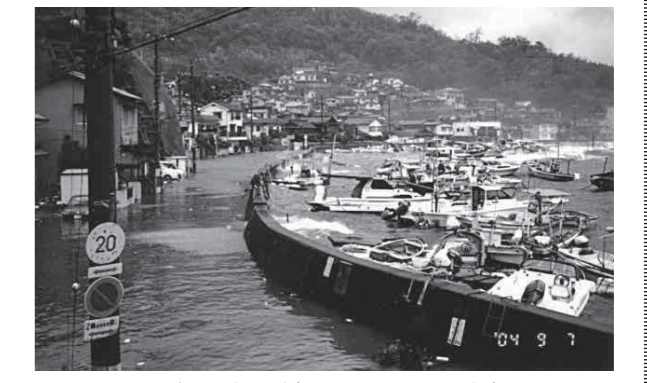
平成16年 横浜地区の台風被害
