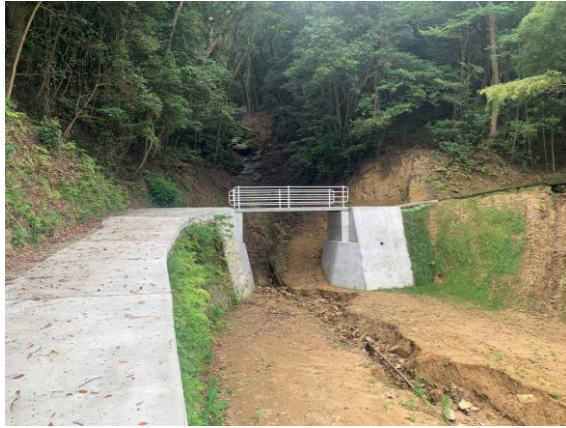
上条19号線（嶽橋：町施工）
