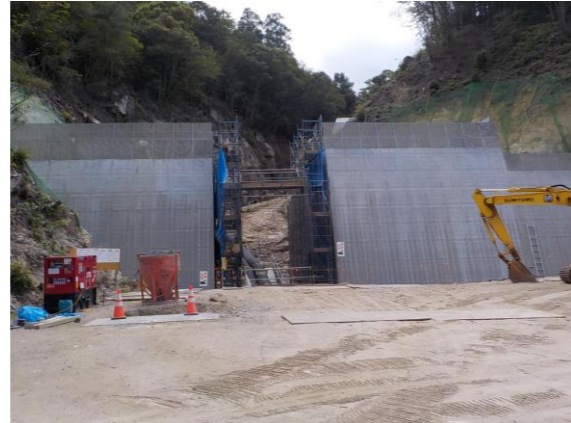
天地川(Ⅲ-1)（小屋浦四丁目：広島県施工）
