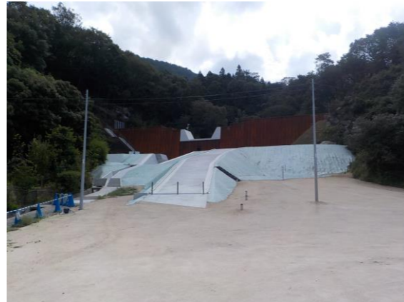
亀石川2（亀石山：広島県施工）
