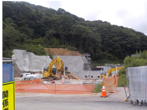
総頭川（総頭山：国土交通省施工）
