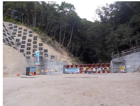
天地川支川1-5（小屋浦地区：広島県施工）
