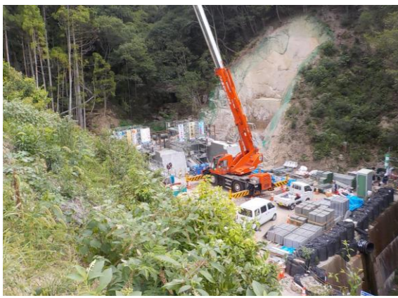
天地川支川1-2（小屋浦地区：広島県施工）
