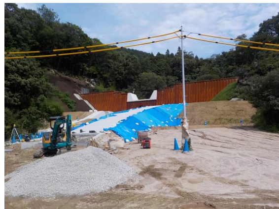
亀石川2(亀石山：広島県施工)
