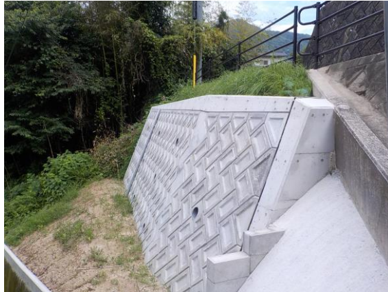
森条火葬場線(坂地区：坂町施工)
