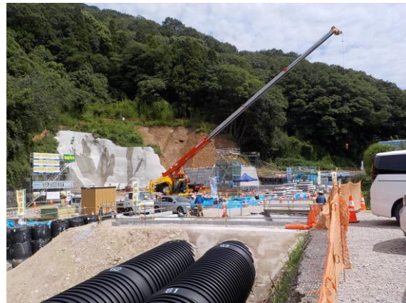
総頭川(総頭山：国土交通省施工)
