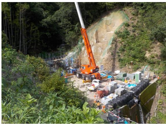
天地川支川1-2(小屋浦地区：広島県施工)
