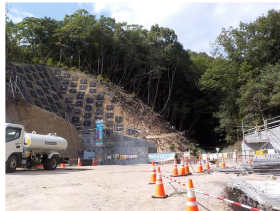
天地川支川1-5(小屋浦地区：広島県施工)
