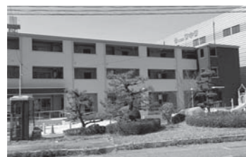
10月 小屋浦みみょう保育園園舎完成
