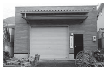
令和5年3月 坂町文化財倉庫完成
