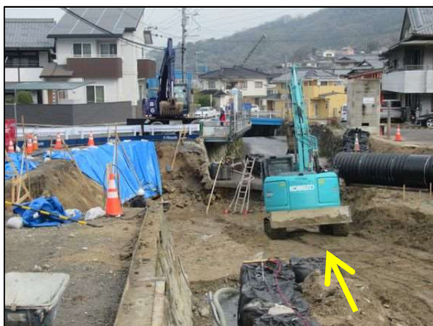
川の流れを縮小、又は迂回して、護岸の工事から施工します。
