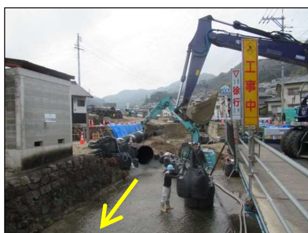
川の流れを縮小、又は迂回して、護岸の工事から施工します。
