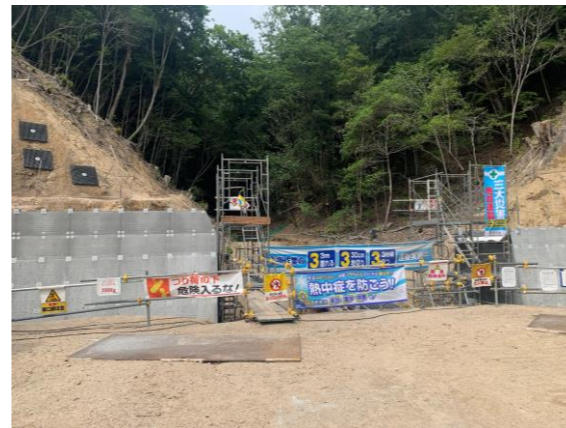
天地川支川 1-5 (小屋浦地区：広島県施工)
