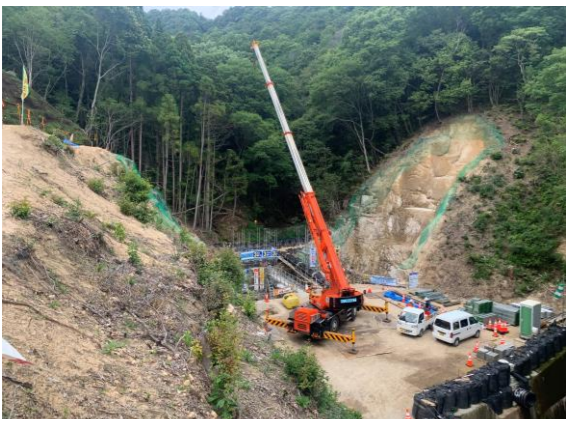
天地川支川 1-2(小屋浦地区：広島県施工)
