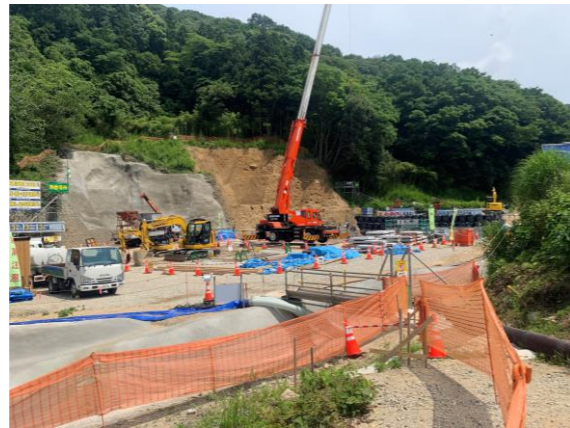
総頭川(総頭山：国土交通省施工)
