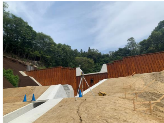
亀石川 2 (亀石山：広島県施工)
