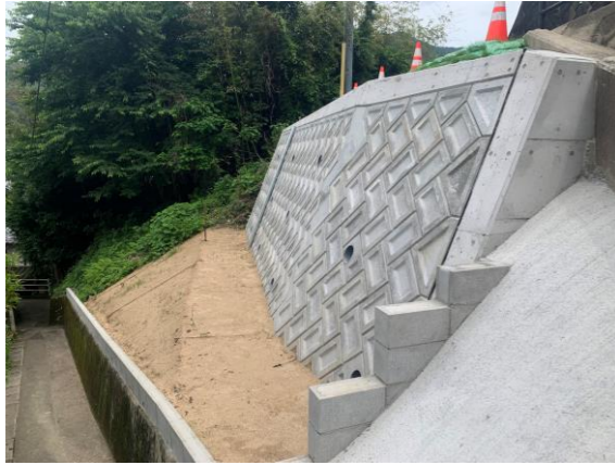
森条火葬場線(坂地区：坂町施工)
