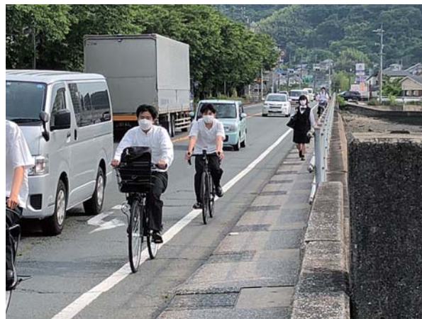
4車線化・歩道拡幅整備予定箇所
