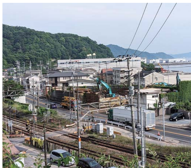
活性化調査が始まる小屋浦一丁目地区
