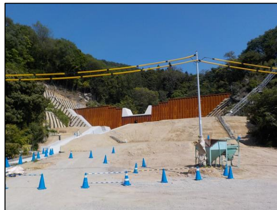
亀石川2(亀石山：広島県施工)
