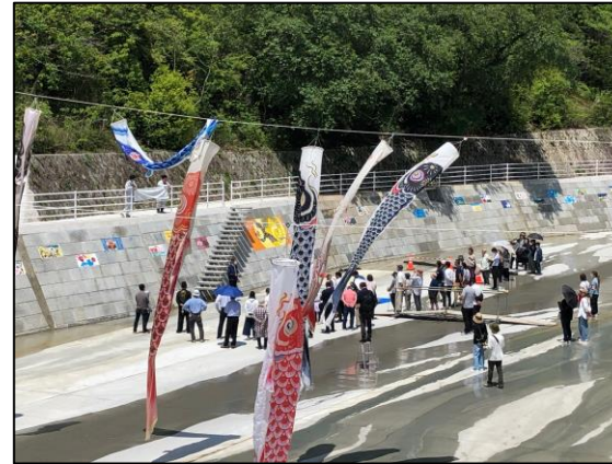
天地川堆積工(小屋浦4丁目：広島県施工)
