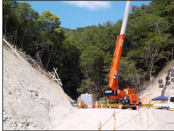
天地川支川1-5(小屋浦地区：広島県施工)
