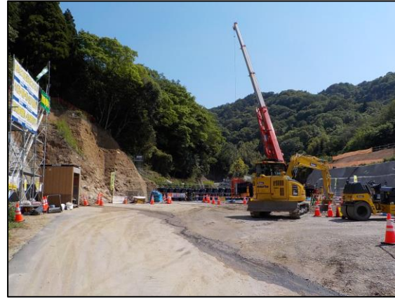
総頭川(総頭山：国土交通省施工)
