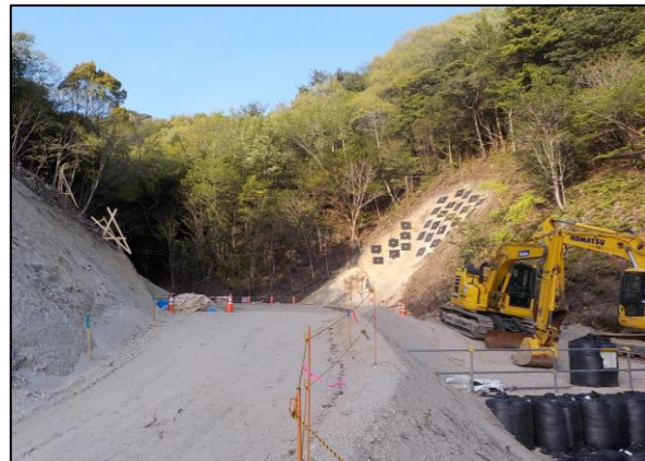
天地川支川1-5(小屋浦地区：広島県施工)
