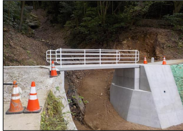
上条19号線(嶽橋：町施工)
