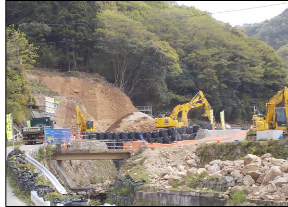
総頭川(総頭山：国土交通省施工)
