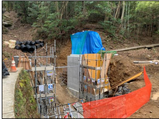
上条19号線(嶽橋：町施工)
