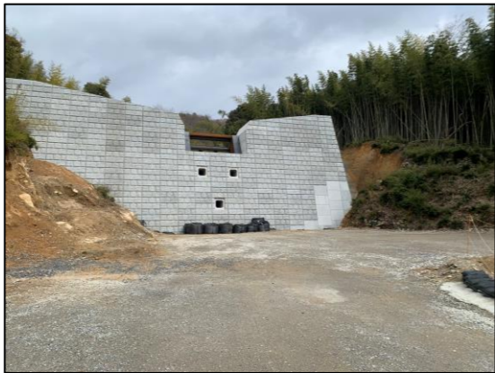
水尻川支川3(水尻：広島県施工)
