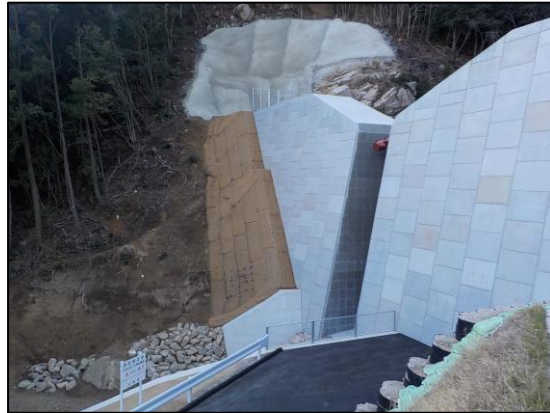
天地川支川3(小屋浦地区：広島県施工)
