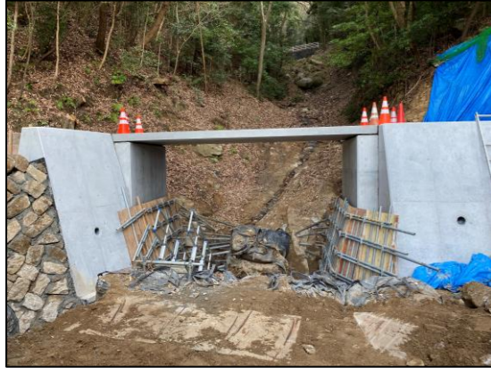
上条19号線(嶽橋：町施工)
