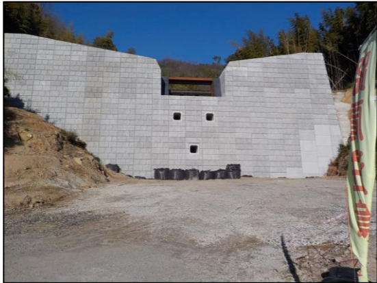
水尻川支川3 (水尻：広島県施工)
