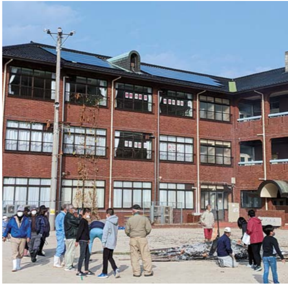
小屋浦小学校の太陽光パネル
