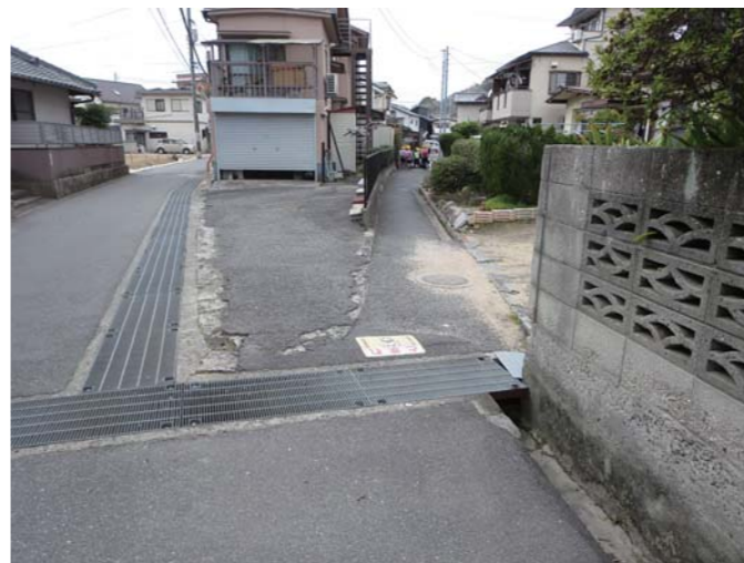
横浜排水区の雨水排水路改良工事
