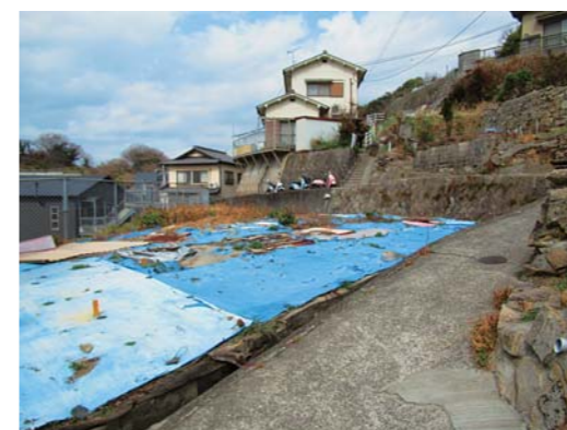
完成が待たれる横浜西の道路改良工事
