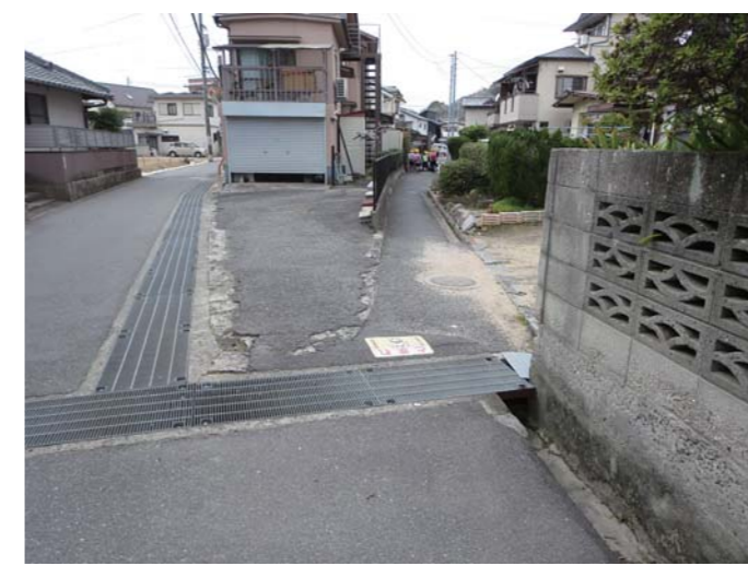
横浜排水区の雨水排水路改良工事
