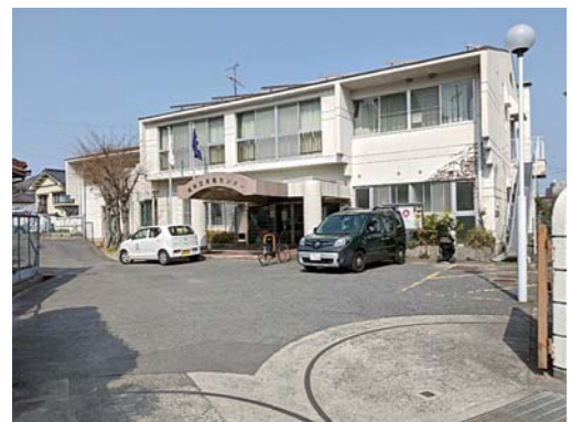
老朽化した保健センター
